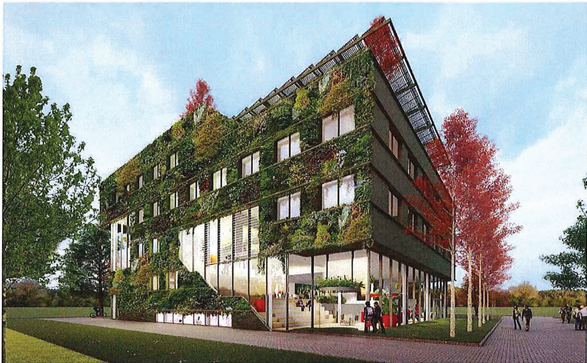
Figuur 1. Nieuwbouw Aeres Hogeschool locatie Almere (gereed september 2021)
